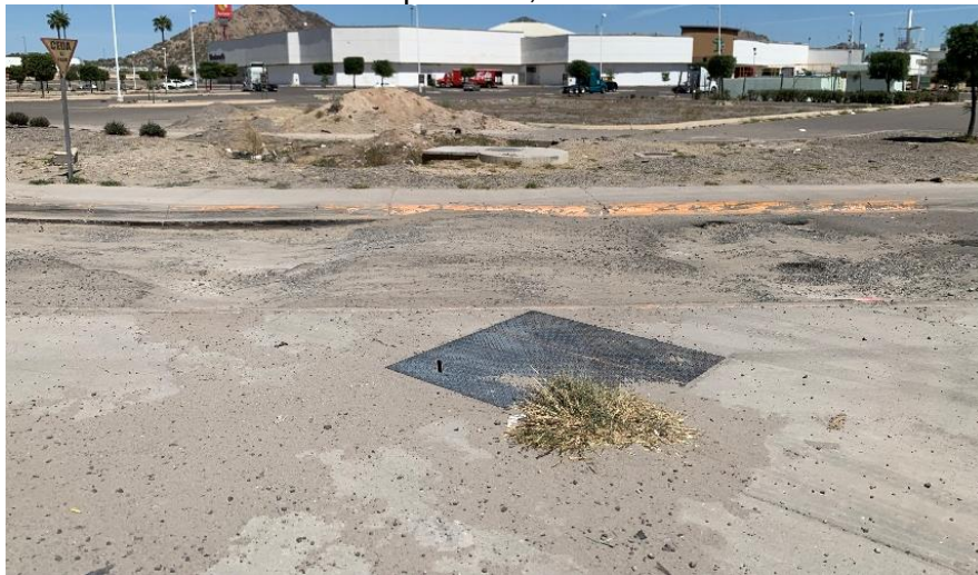
Carril de incorporación, sección noroeste
